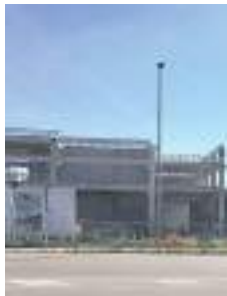
Il cantiere della Pte
