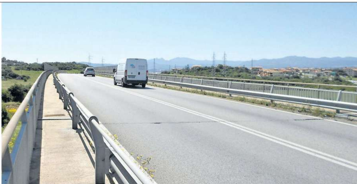
Un tratto della strada tangenziale costruita dal Cipnes che circonda parte della città
