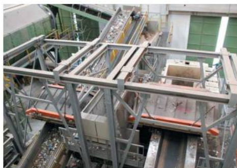
L'impianto di trattamento. In alto, la discarica di Spiritu Santu
